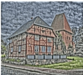
Kirche mit ehemaligem Zollhaus in Hernburg
