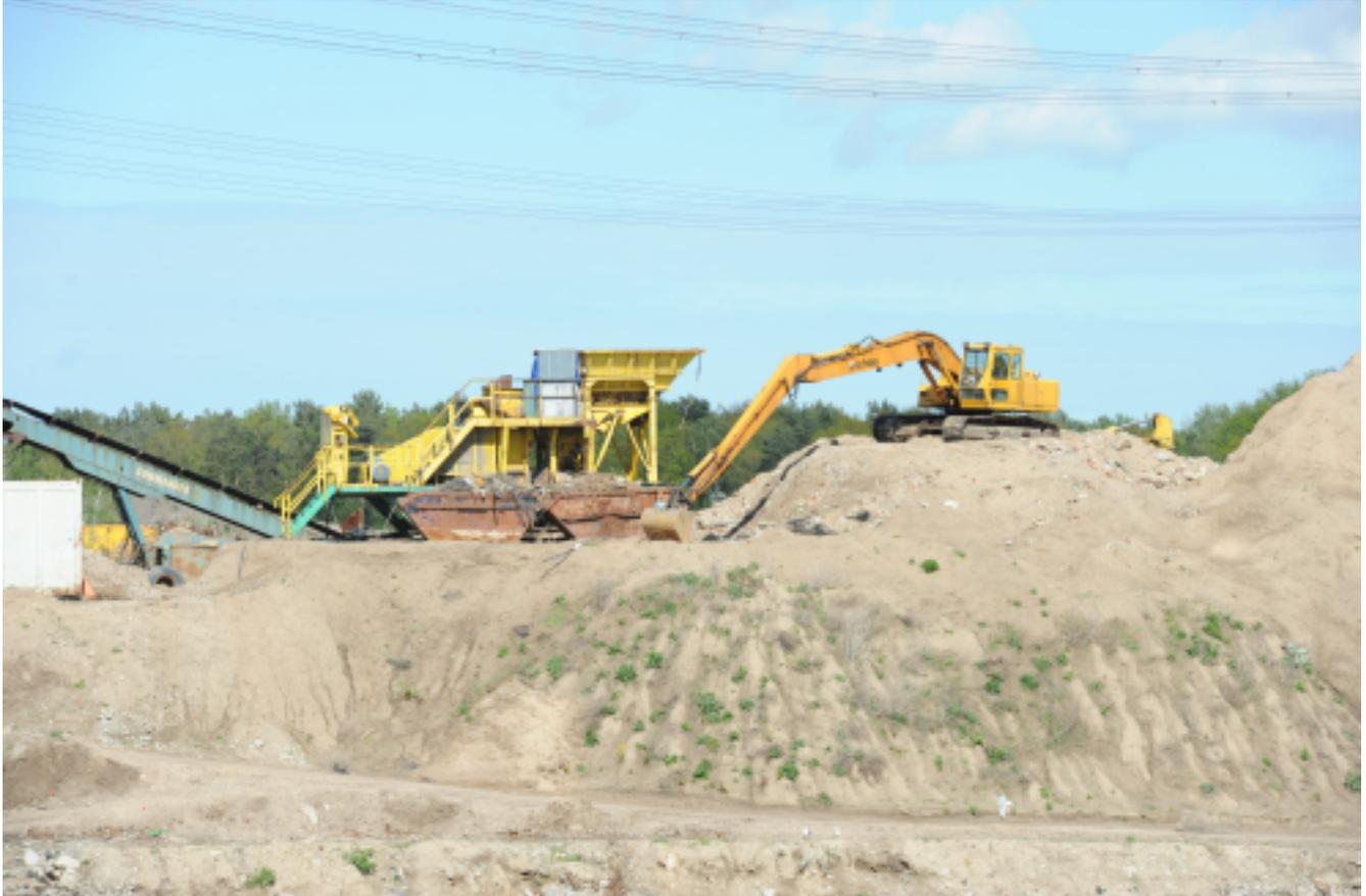
Bild 3.16, Mai 2010 Die letzten Reste werden zerkleinert, Baustahl, Metalle und andere Fremdstoffe aussortiert, der mineralische Schutt angeschüttet oder für andere Verwendungen, z. B. Baustraßen abtransportiert
