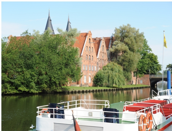
Zalzspeicher und Holstentorbrücke
